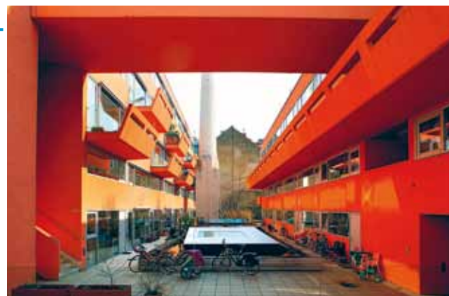
Innenhof der Sargfabrik, Wien, BKK-2, 1992–96
